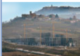
Il cantiere del Nuovo Ospedale - novembre 2010
