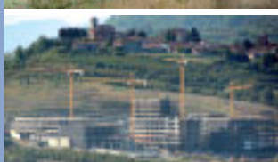
Il cantiere del Nuovo Ospedale - settembre 2010
