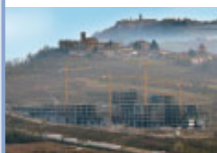
Il cantiere del Nuovo Ospedale - novembre 2010
